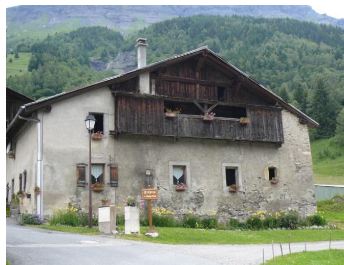
Ferme ancienne au Nivorin Les ouvertures du niveau inférieur sont petites
