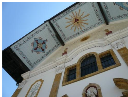
Détail de la passée de toit. Elle a bénéficié des dons de riches émigrés installés dans « Les Allemagnes »
