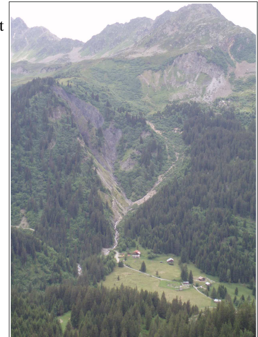
Photo n° 12 : Bassin versant du Nant Borrant, juillet 2011, Source MB Management
