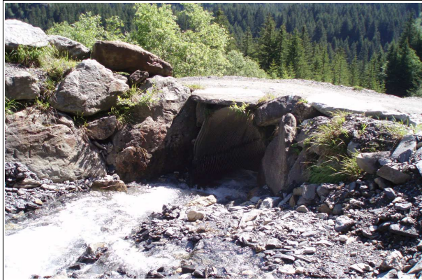
Photo n° 11 : Buse pour passage de la piste au Nant Borrant, juillet 2011, Source MB Management
