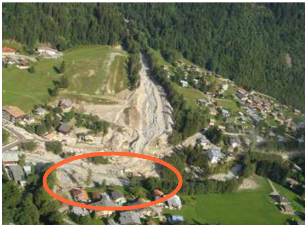
Photo n°8 : Erosion de berge au Hameau de la Vy suite à la crue de l'Armançette, août 2005, Source RTM
