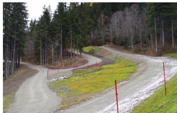
Photo : après les travaux de terrassement et le profilage des pistes, le domaine nordique se prépare à accueillir les fondeurs
