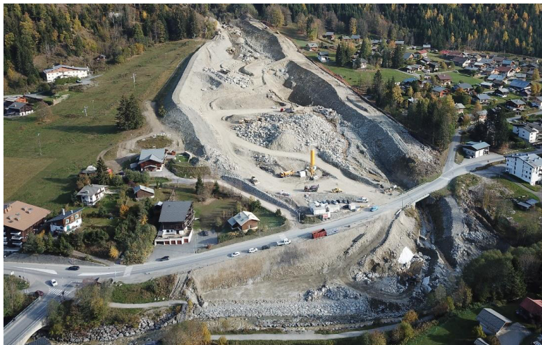
Photo : vue aérienne des travaux de sécurisation du Nant d'Ar Mancette
