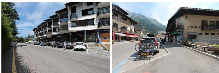
Stationnement en surlargeur de la voie, même revêtement en enrobé
