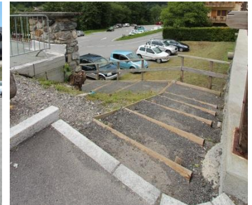
Aménagement récent d'un escalier pour rejoindre le parking central
